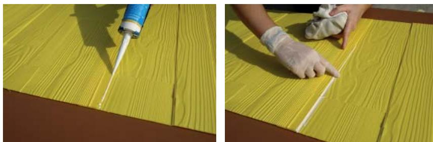
5.- Assemblage des panneaux sans les sceller, (empreinte visible sur la face du béton). attention Il est possible que le béton pénètre entre les matrices lors du coulage de celui ci.
